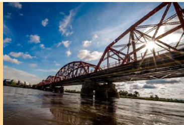
Puente carretero, Santiago del Estero.
