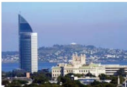
Torre de las Comunicaciones - Antel
