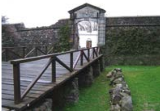
Puerta de Colonia del Sacramento
